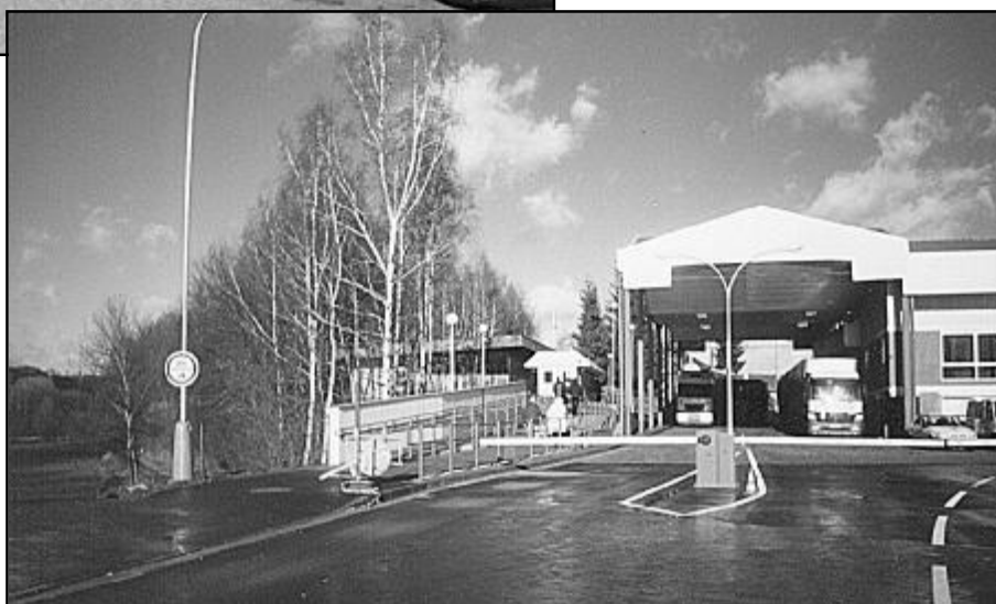
K rampě byl přistavěn další krytý prostor pro odbavení nákladních vozidel. Pro procházející osoby byl vyčleněn chodník vlevo od rampy včetně kontrolních stanišť pro celníky.
